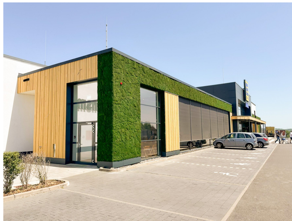
SEITENFASSADE · MATERIALKOMBINATION MOOS UND HOLZ
